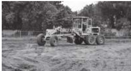
Continúan trabajos de rehabilitación al interior del deportivo Villa de las Flores
